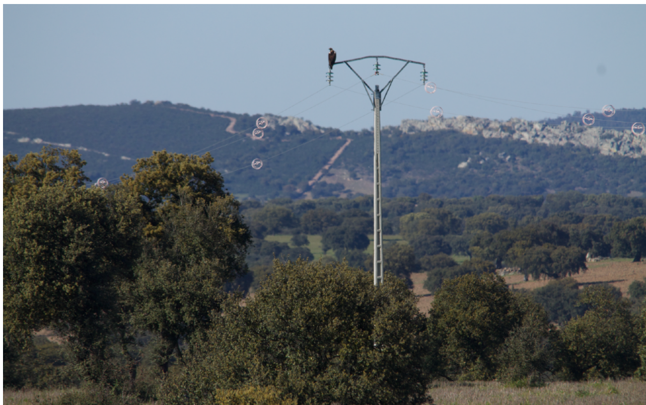
Fotografía 4 /Photograph 4: adulto posado en una torreta eléctrica próxima a su nido / adult perched on an electrical transmission tower near its nest. R. Sánchez 2015 ©.
